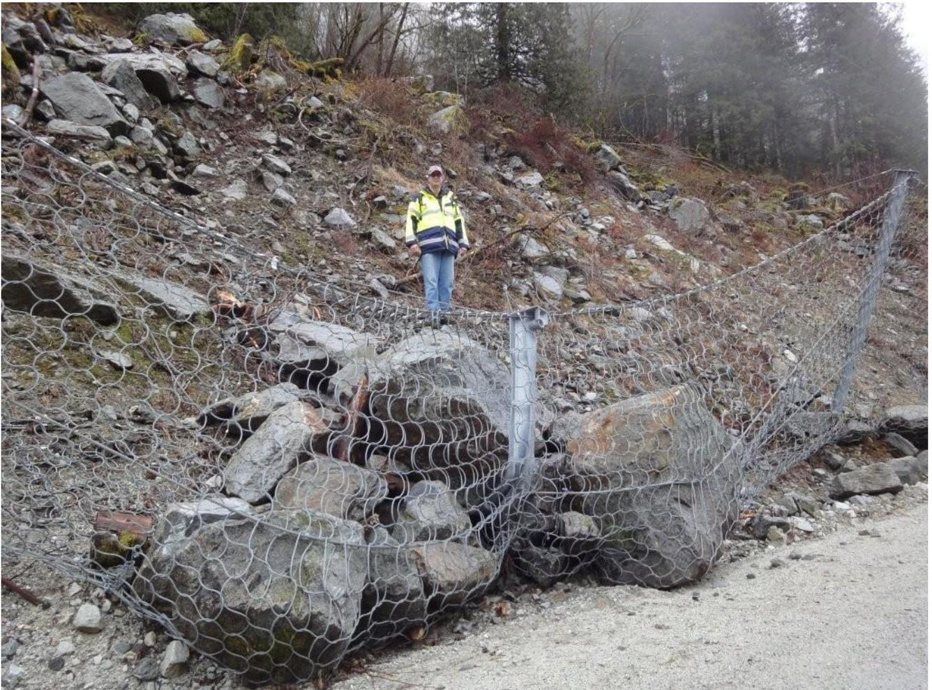
Die Netze sind aus Stahlseilen geflochten und deshalb sehr stark. Sie halten die herunterrollenden Gesteine einfach auf. Genau den gleichen Zweck haben auch die Holzwände. Netze und Wände werden so aufgestellt, dass sie in der Sturzbahn des Gesteins stehen. **Die beste und günstigste Schutzmaßnahme ist aber, den Steinschlagbereichen fern zu bleiben!**
